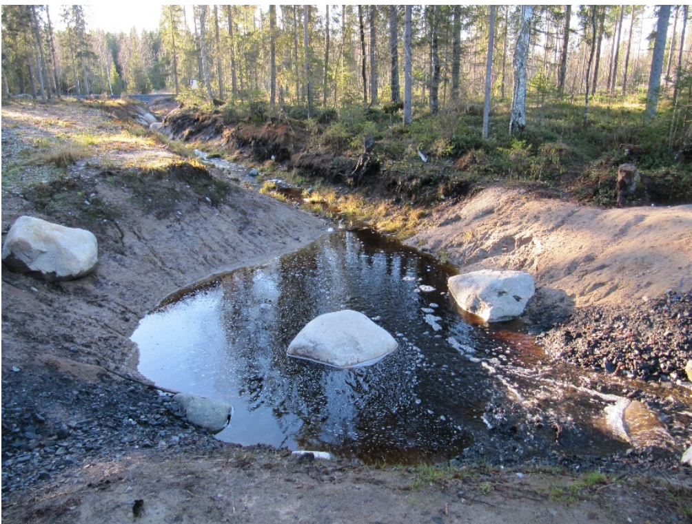
Kuva 28. Pohjapadon jälkeen on pieni vesialla, johon johdetaan myös viereisen alueen kuivatusvesiä. Tästä kosteikolla käsitellyt hulevedet ohjataan Kokelinojaan n. 50 m päähän. Kuvattu 30.10.2020
