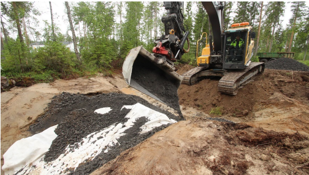
Kuva 26. Kiviverhoiltu pohjapato vahvistettiin kankaalla. Kuva: Juha Siekkinen, Kosteikkomaailma 1.7.2020
