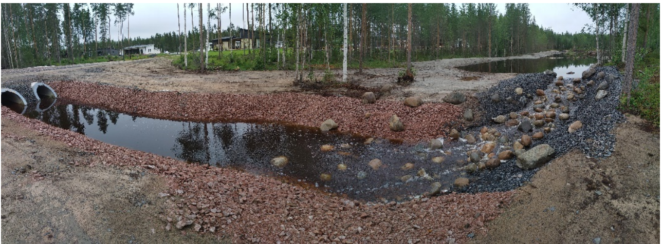
Kuva 21. Itäisen hulevesikosteikon kiviverhoiltu pohjapato ja vesienohjaus takaisin Kokelinojan nykyiseen uomaan. Kuvaaja: Juha Siekkinen, Kosteikkomaailma 24.7.2020
