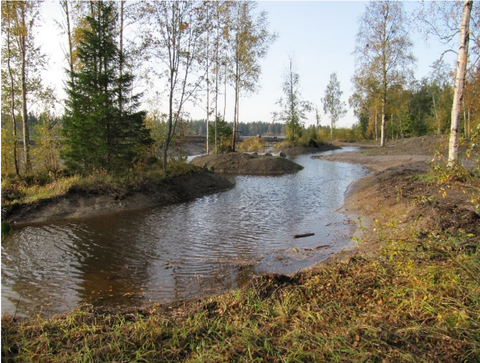
Kuva 14. Näkymä hulevesikosteikolle Ruottalontieltä merelle päin. Ruottalonlahden hulevesikosteikolle jätettiin kaksi kuivapintaista saarta. Kuvattu 25.9.2020.
