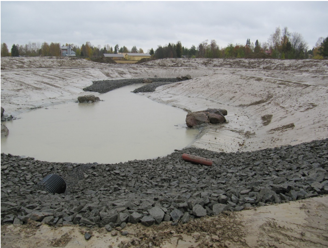
Kuva 5. Näkymä vasta perustetulle Taanilan kosteikolle eteläpäästä, jossa hulevedet laskevat kosteikkoon. Purkuputken (musta) ja tulvapuskeen (punaruskea) suiden alue on kivetty. Taaempänä näkyvä kivetty alue sisältää biohiilikerroksen. Kuvattu 6.10.2020
