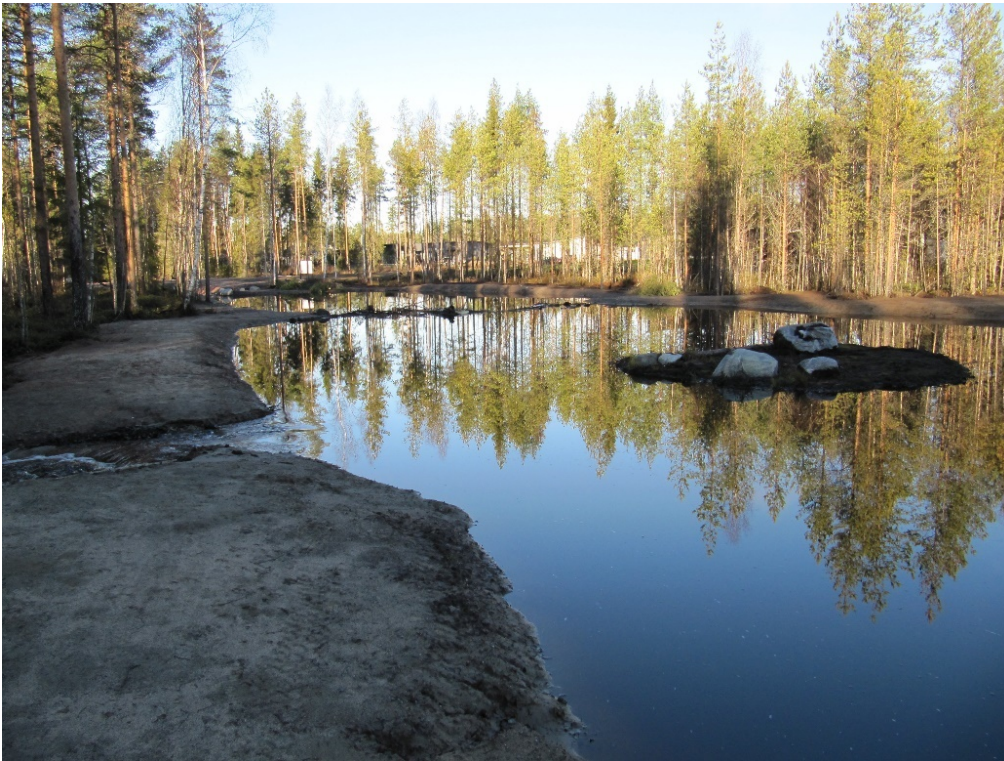
Kuva 20. Itäiselle hulevesikosteille tehtiin pohjapadon lisäksi tulvakynnys, joka näkyy kuvassa vasemmalla. Kuvattu 30.10.2020
