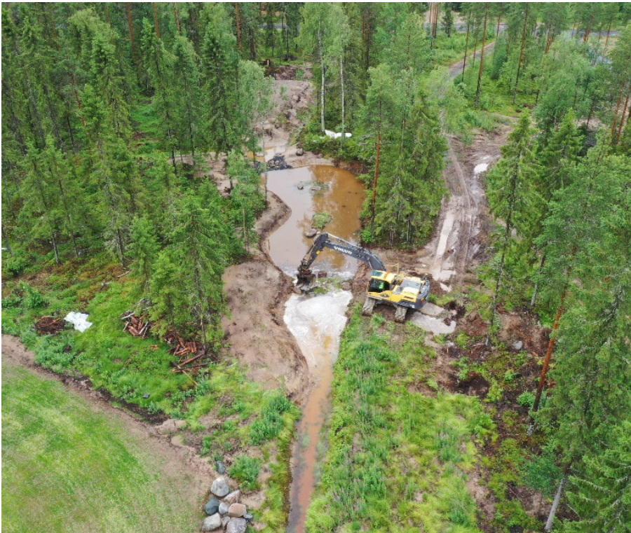
Kuva 23. Lätisen hulevesikosteikon työmaa kuvattuna pohjoisesta etelään päin. Hulevedet tulevat kosteikolle kuvan alalaidassa näkyvää uomaa pitkin. Kiviverhoilu pohjapato näkyy uoman toisessa päässä. Sieltä vedet ohjataan ojaa pitkin Kokelinojaan. Kuvaaja: Juha Siekkinen, Kosteikkomaailma, 3.7.2020
