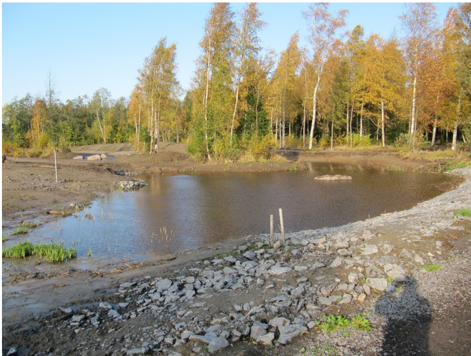
Kuva 13. Hulevesikosteikon alkupää, johon hulevedet purkautuvat. Tältä ensimmäiseltä allasosalta löytyy laskeutussyvännä kiintoaineen poistoa varten. Kuvattu 25.9.2020
