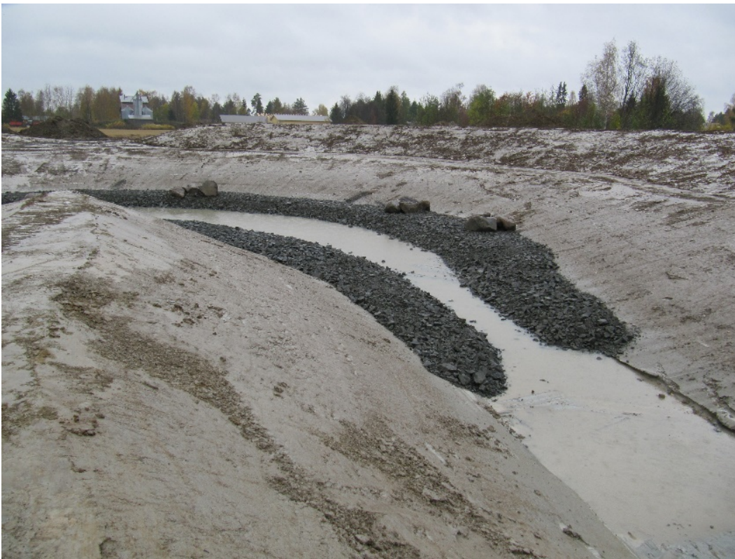
Kuva 7. Biohiiltä on murskeen sisällä n. 10 cm vahvuisena kerroksena. Murske pitää sen paikoillaan ja estää sen huuhtoutumisen hulevesien mukana Katajaojaan. Kuvattu 6.10.2020
